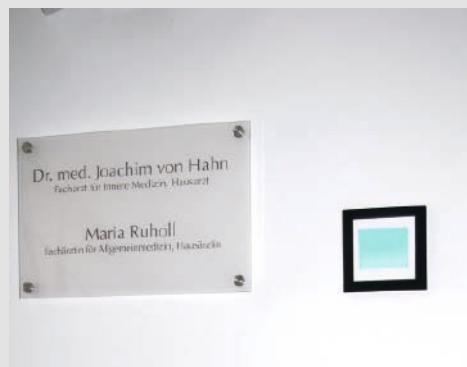
Abb.13: Beispiel einer zusätzlichen optischen Anzeige der Türöffnung im Treppenhausebereich
