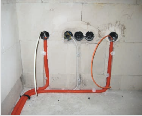
Abb.34+35: Beispiele einer Elektroinstallation im Rohbau
