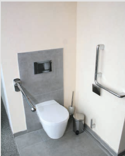
Abb.54 (links): Beispiel einer kontrastreichen Gestaltung eines WCs mit Haltegriffen
