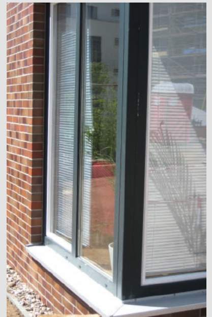
Abb.40: Beispiel einer bodentiefen Überdeckverglasung (französisches Fenster)
