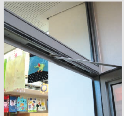
Abb.21: Integrierter Türschließer mit stufenlos einstellbarer Schließkraft und Schließverzögerung
