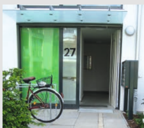
Abb.16: Beispiel eines barrierefreien Hauseinganges mit Glasdach
