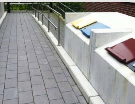
Abb.3: Durch eine Rampe ist hier ein Anteil der Mülltonnen barrierefrei erreichbar
