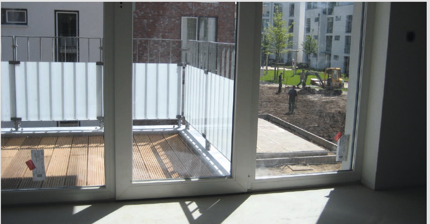
Abb.43: Wenn es mehrere bodentiefe Fenster gibt, ist es sinnvoll den Balkon so anzuordnen, dass dieser mindestens ein Fenster oder Fensterelement frei lässt. Sitzende oder liegende Personen im Raum können so unbeeinträchtigt von der Balkonbrüstung ins Freie blicken. Eine möglichst transparente Gestaltung der Balkonbrüstung (Sicherheitsglas oder filigrane Stahlkonstruktion) tragen zur Verbesserung der Ausblickssituation und auch zur Optimierung der Raumbelichtung bei
