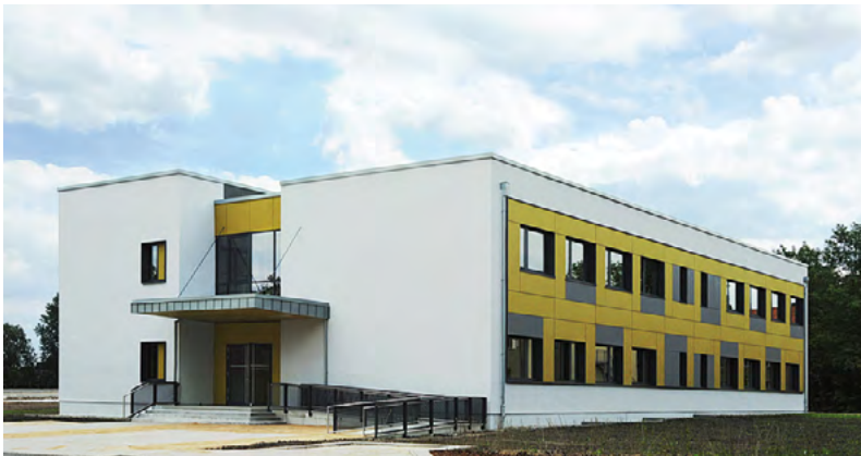
Abb. 33 Nordeingang und Westfassade
