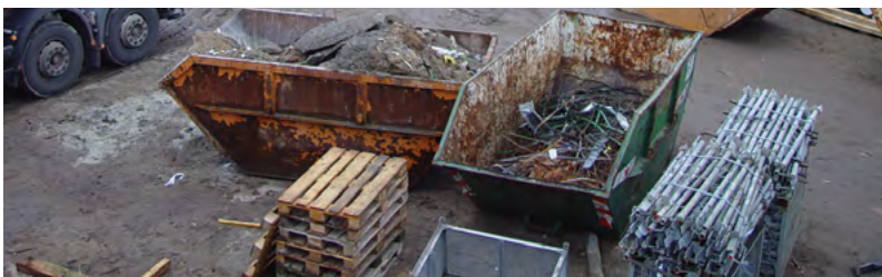
Abb. 31 Trennung von Baustellenabfällen
