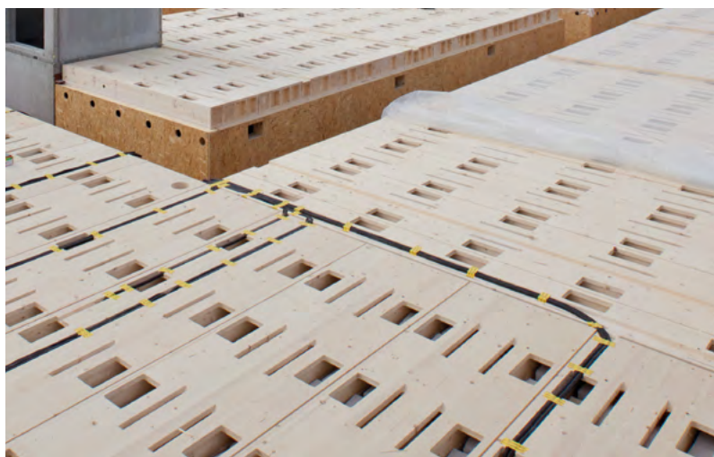
Abb. 28 Leicht trennbare Deckenkonstruktion ohne feste Verbindungen
