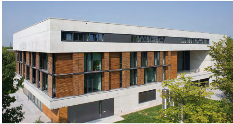
Abb. 44 Blick auf das Institut für Immobilienwirtschaft aus Südwest
