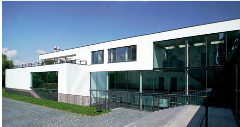
Abb. 40 Blick vom Verbindungstrakt auf die Südfassade
