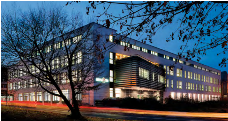
Abb. 45 Südostecke mit Eingangsbereich
