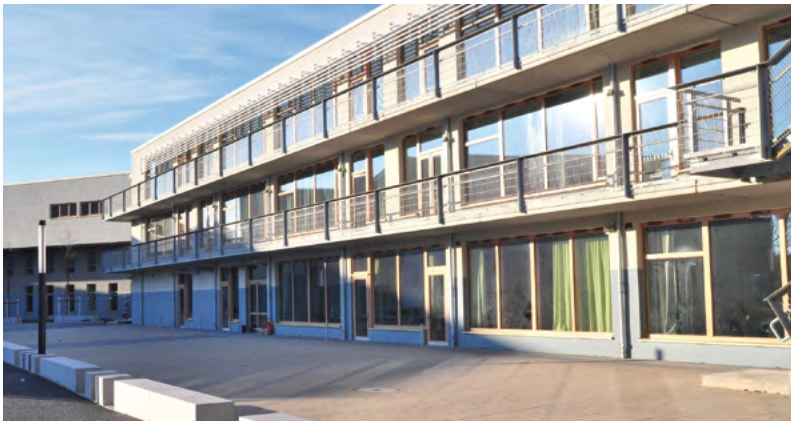
Abb. 37 Ostfassade im Innenhof
