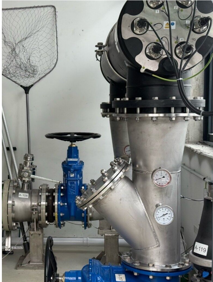
UV-Filterung und Molch-Stutzen
