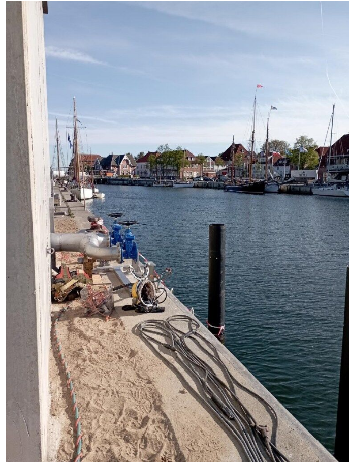
Anbindung der Entnahmekonstruktion
