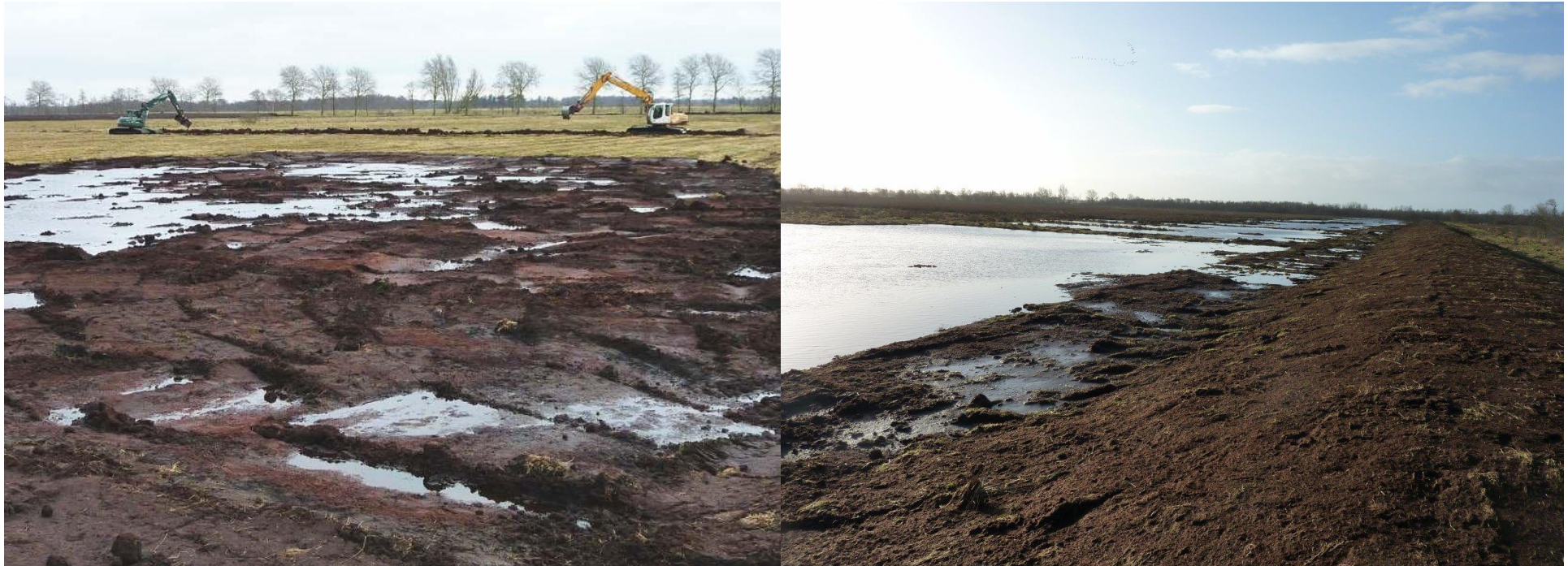
Dränagerückbau & Verwallung der Polder
