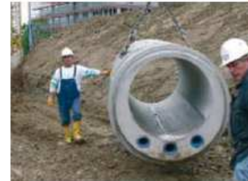
Bild 9: Kanalrohr mit Wärmetauschern in Längsrichtung. (Fotos: KOBEL, B. Ryser Ingenieure AG; SCHMID, F. eam)
