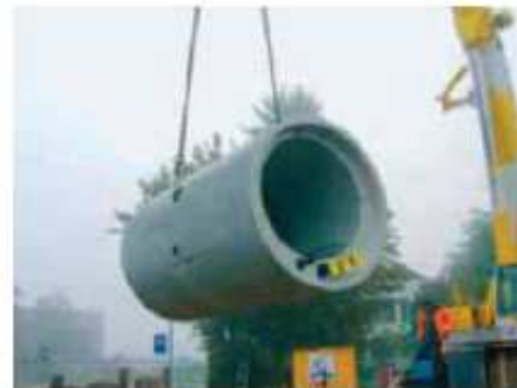
Bild 9: Kanalrohr mit Wärmetauschern in Längsrichtung. (Fotos: KOBEL, B. Ryser Ingenieure AG; SCHMID, F. eam)
