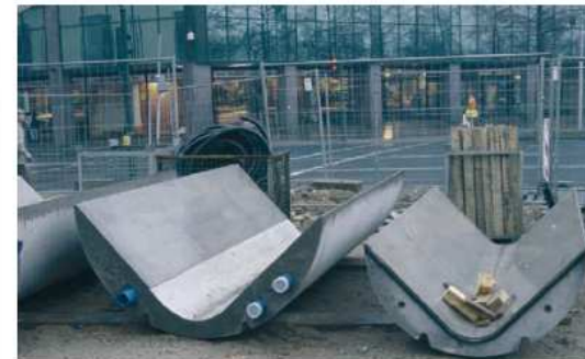
Bild 5: Beispiele von nachträglich eingebauten Wärmetauschern. (Fotos: BURI, R.; KOBEL, B. 2005)
