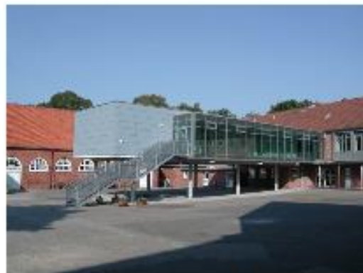
Anbau Klassenräume, Bordesholm (September 2005)
